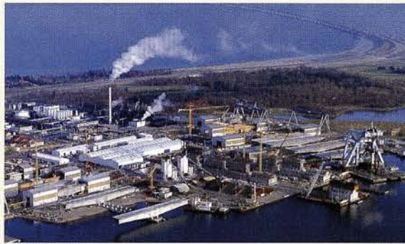
Eine von sechs Baustellen an der Großen-Belt-Querung
